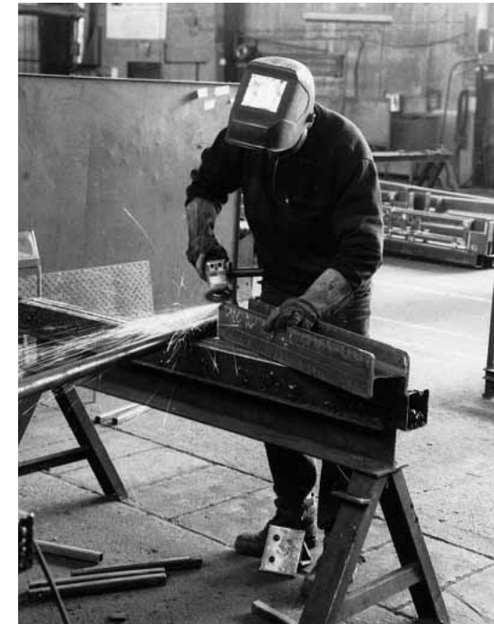
(SLB GmbH – Schleifarbeiten am doppel T Träger)
