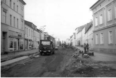
Die Berliner Strasse wird rekonstruiert
