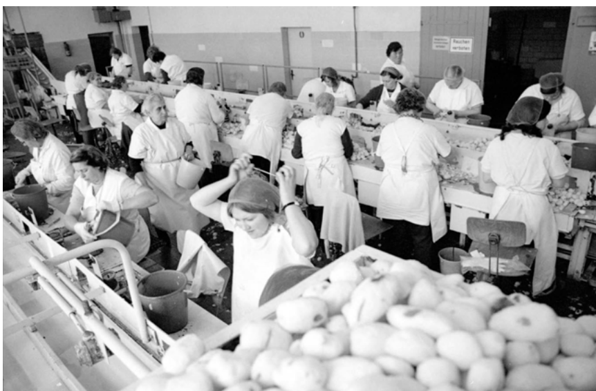
Müncheberg, Kartoffellagerhaus, Schälküche, April 1974
